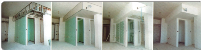
Detalle de emplacado y masillado.
