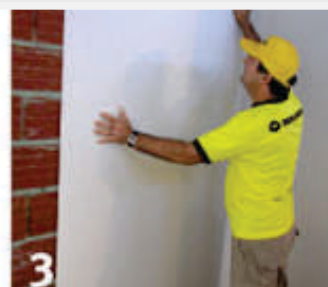
3-PEGUE LAS PLACAS A LA PARED O MURO DE APLOME
